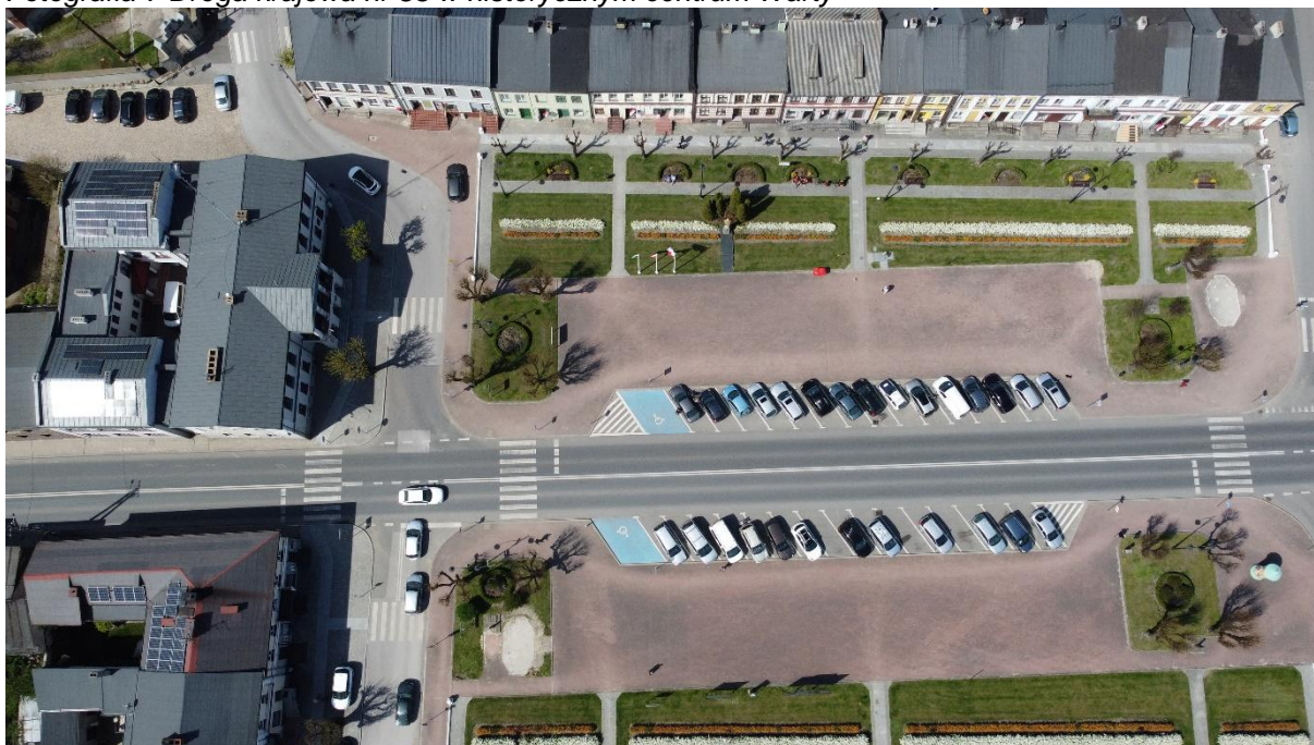
Fotografia 7 Droga krajowa nr 83 w historycznym centrum Warty
