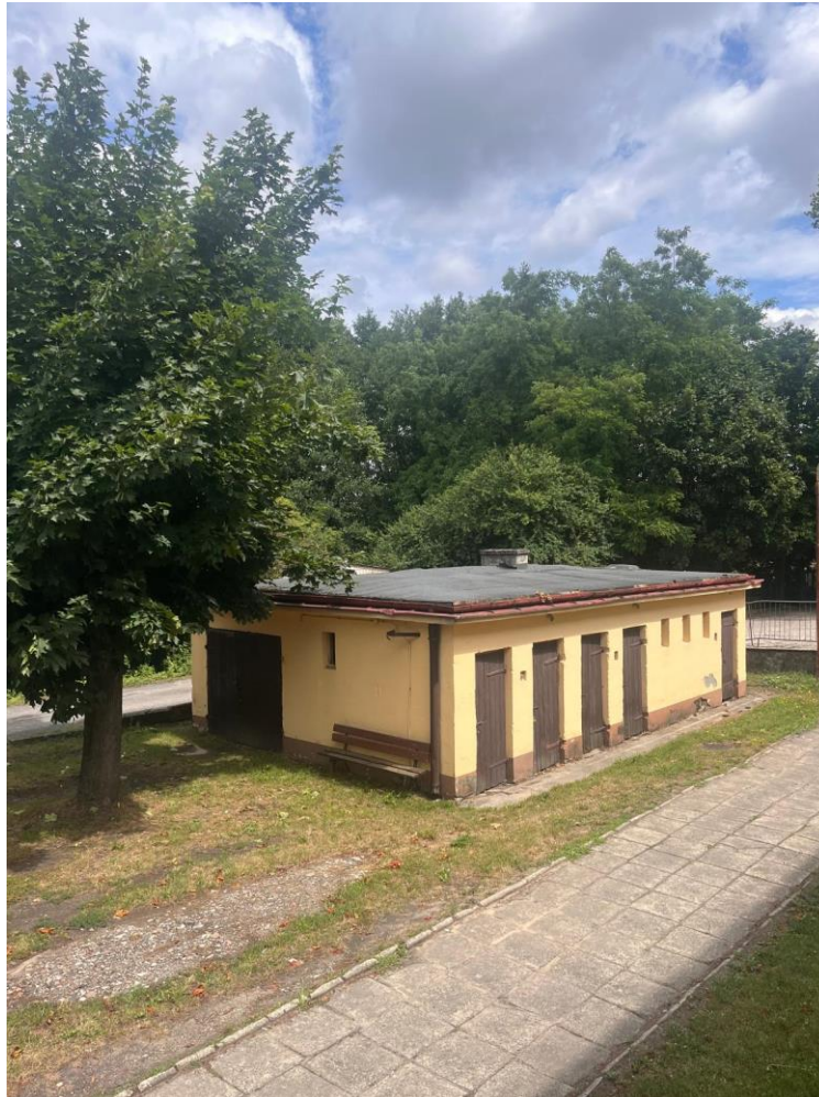
Zdj. 1 Istniejący budynek gospodarczy z pomieszczeniami sanitariatów.
