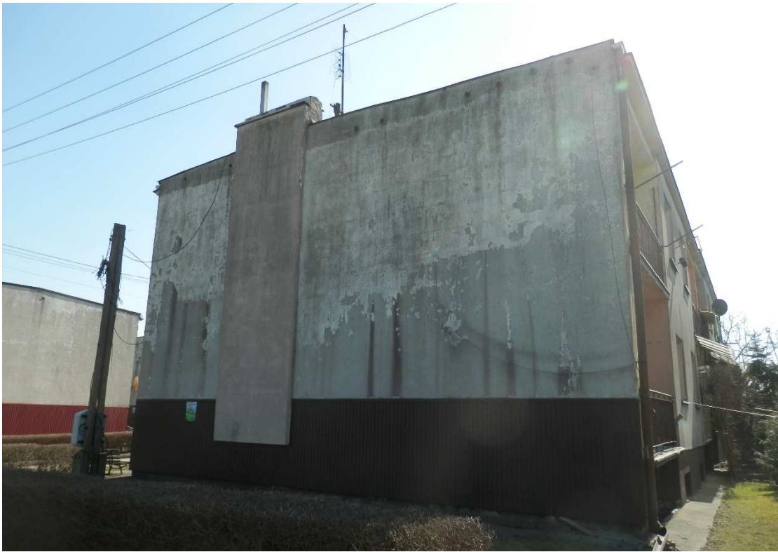
Zdjęcie 1 Elewacja północna
