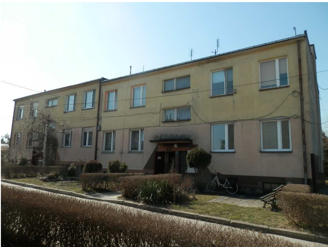
Zdjęcie 4 Elewacja wschodnia
