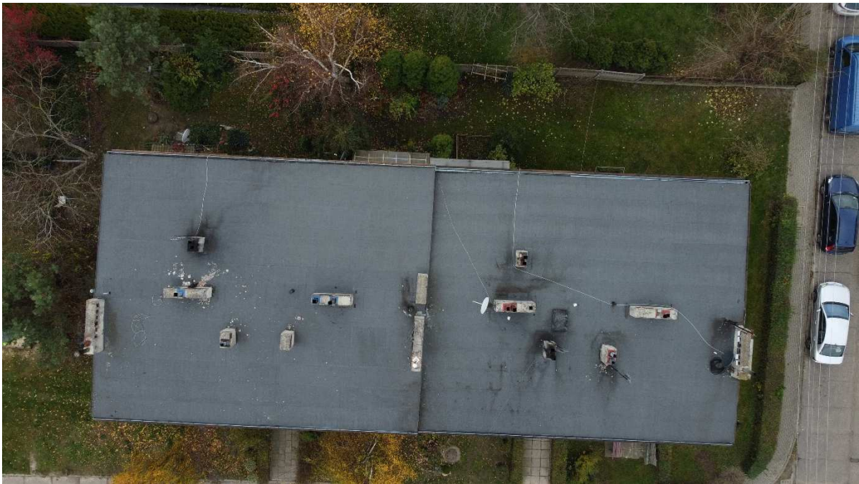
Zdjęcie 5 Widok ogólny dachu budynku
