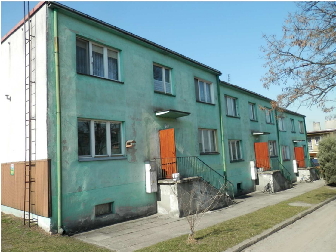
Zdjęcie 4 Elewacja wschodnia
