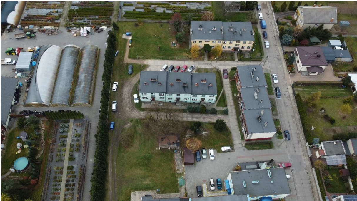
Zdjęcie 5 Widok ogólny dachu budynku
