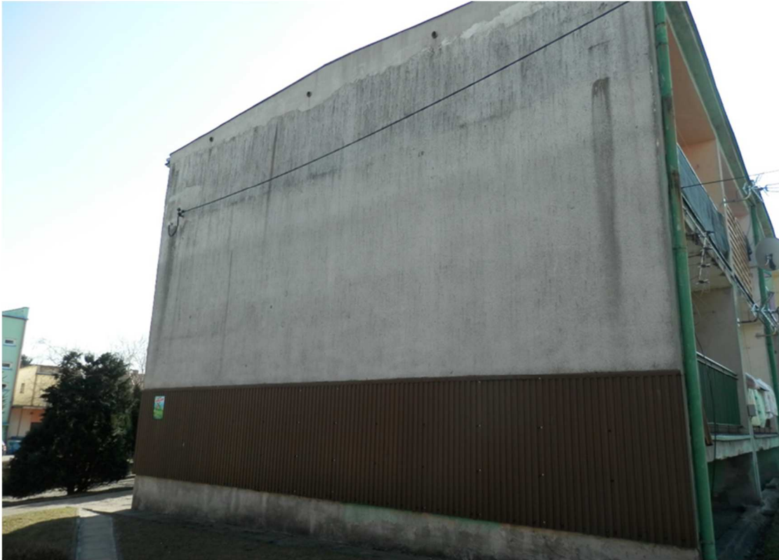
Zdjęcie 1 Elewacja północna
