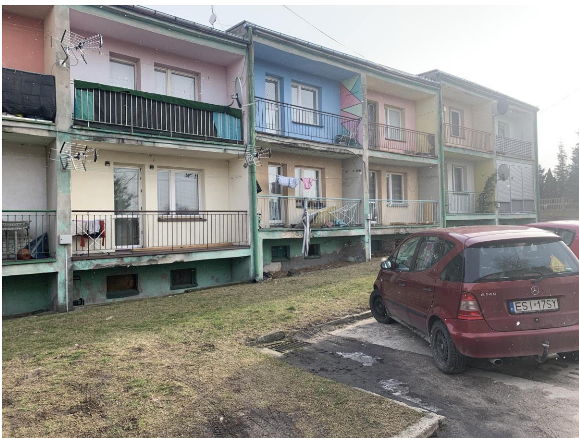
Budynek mieszkalny wielorodzinny przy ul. Popioły 3A w Warcie – elewacja zachodnia
