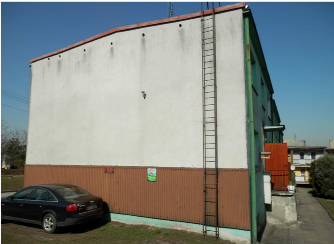
Zdjęcie 2 Elewacja południowa
