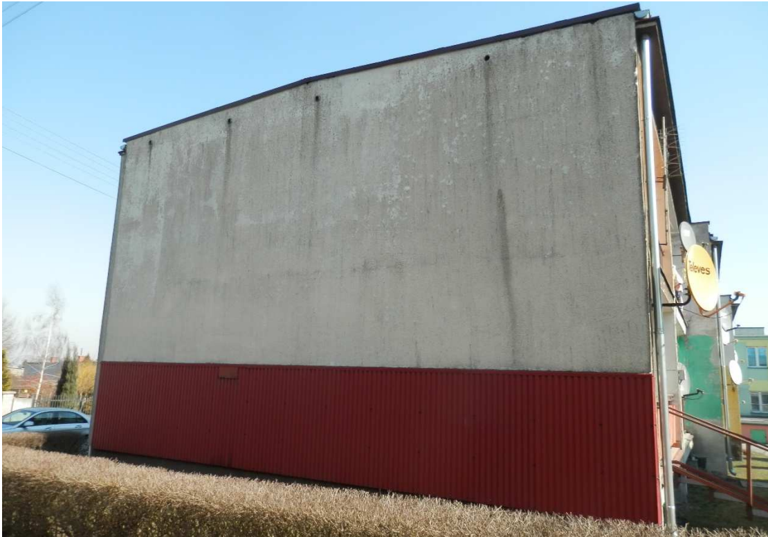
Zdjęcie 3 Elewacja zachodnia
