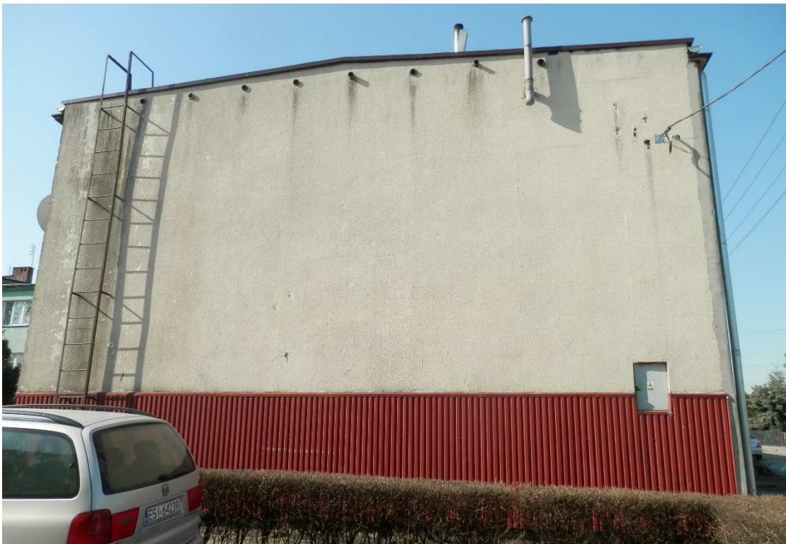
Zdjęcie 4 Elewacja południowa
