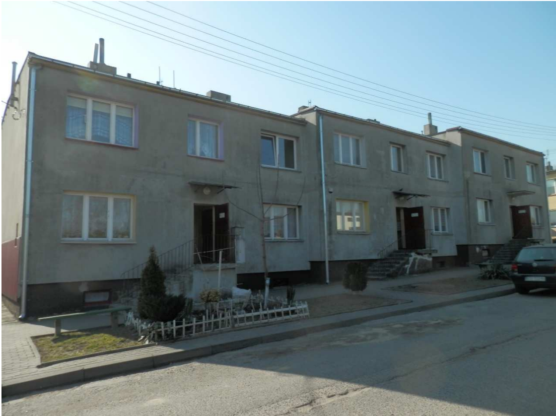
Zdjęcie 1 Elewacja północna
