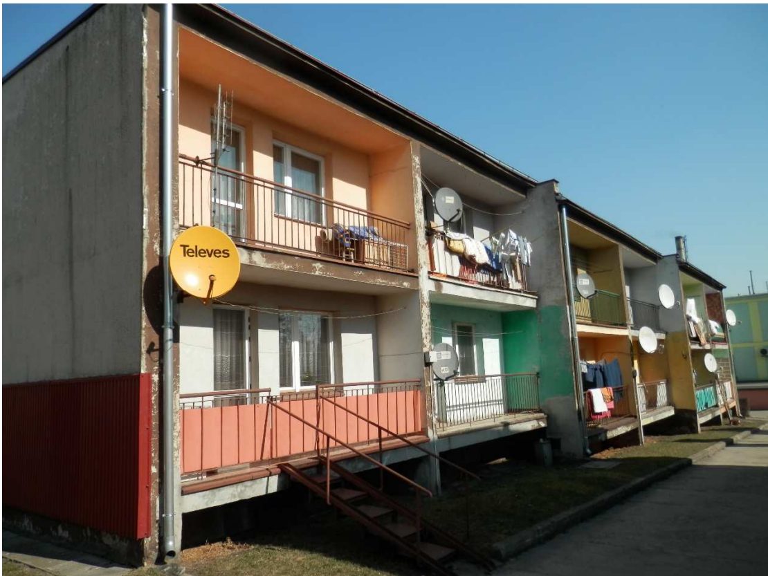
Zdjęcie 2 Elewacja południowa
