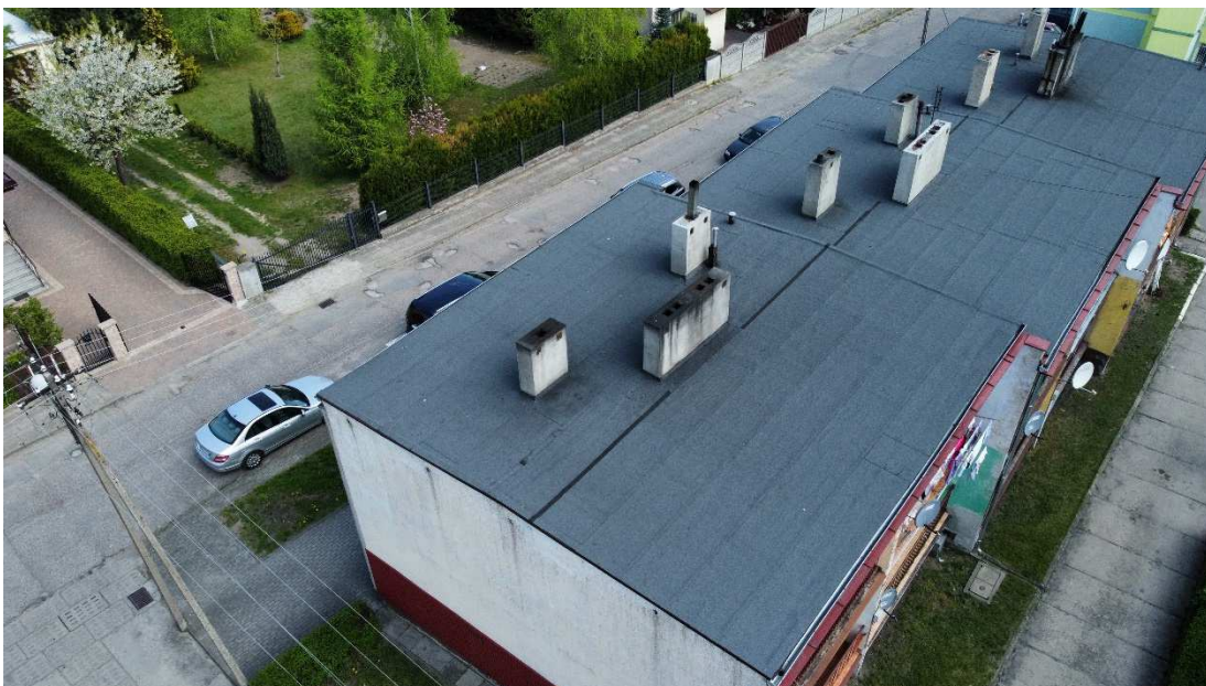
Zdjęcie 5 Widok ogólny dachu
