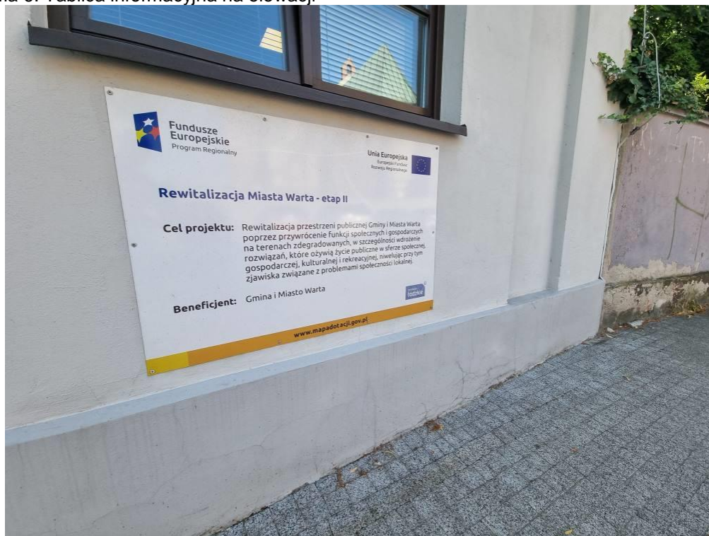
Fotografia 6. Tablica informacyjna na elewacji
