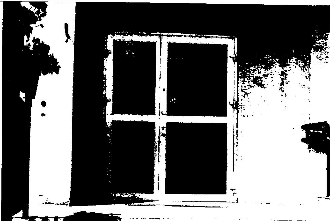
Drzwi do Szkoły, elewacja wschodnia budynku.
