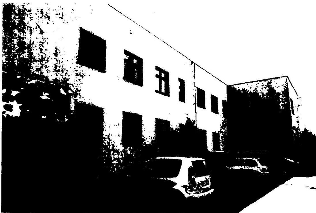
Elewacja zachodnia budynku.
