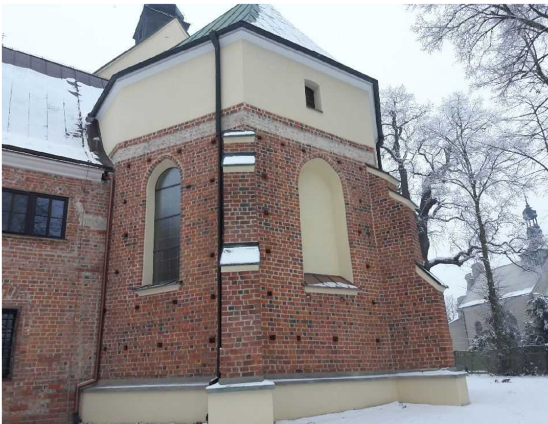
Wyremontowana część kościoła WNP OO. Bernardynów w Warcie
