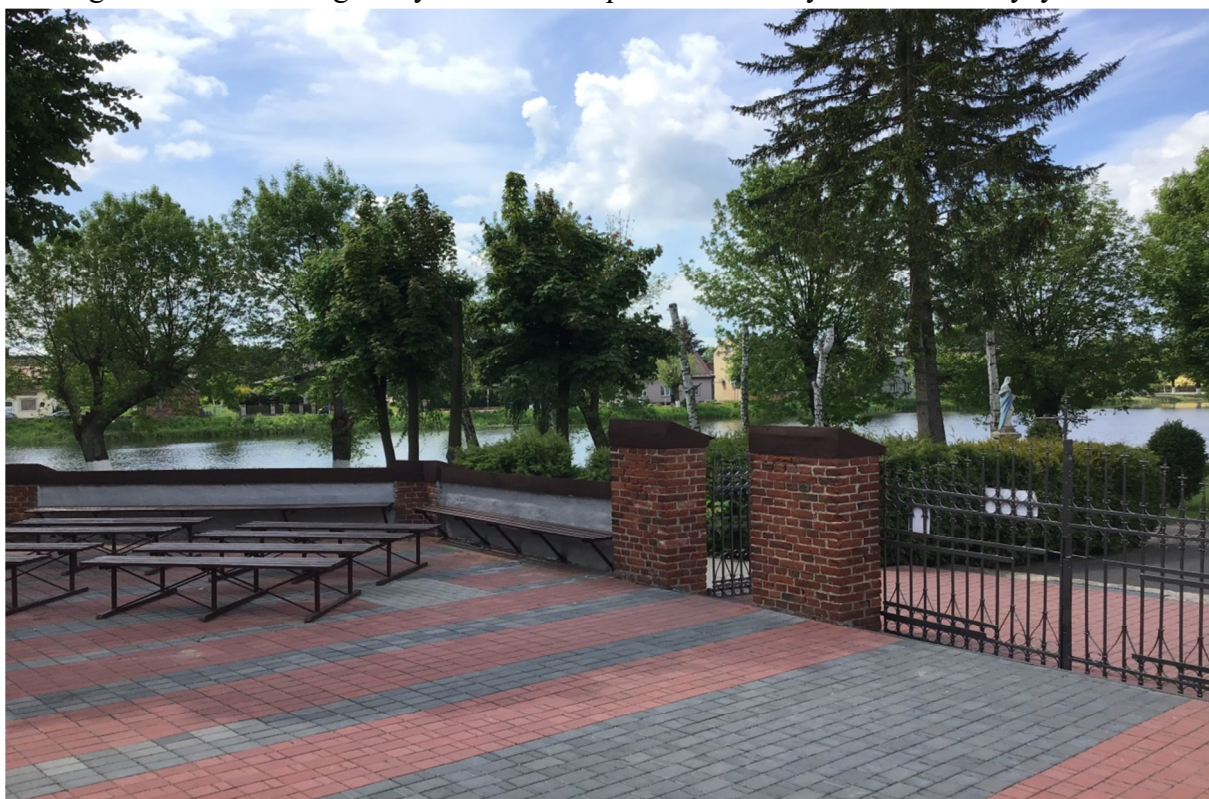
Wyremontowany parkan przy kościele św. Wawrzyńca w Rossoszycy
