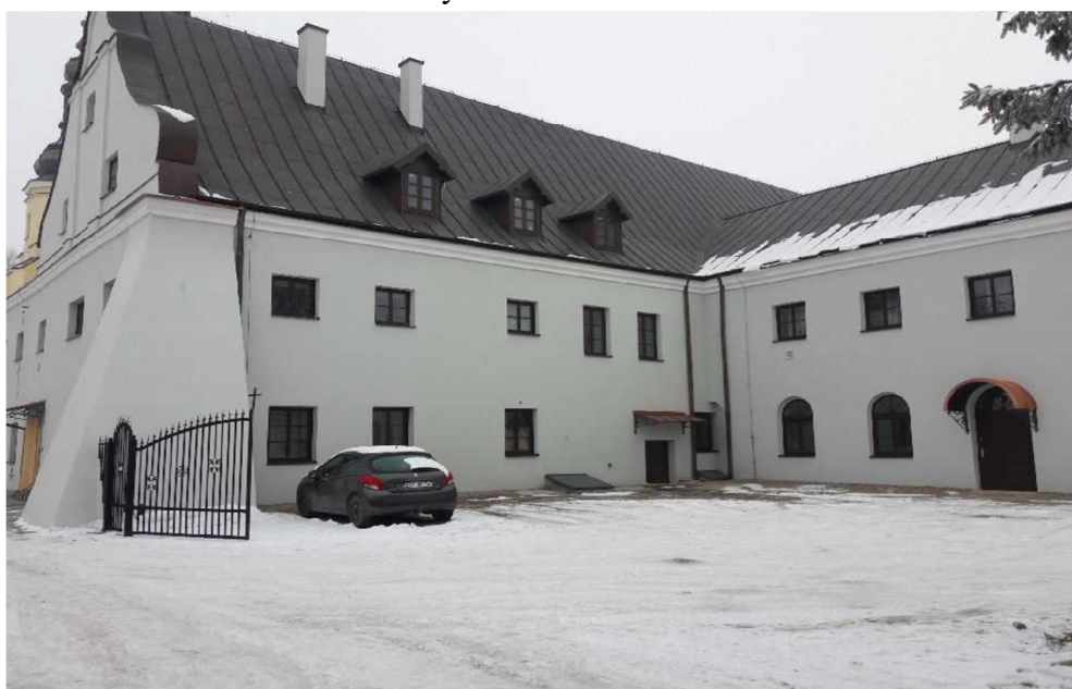
Wyremontowana część klasztoru OO. Bernardynów w Wacie
