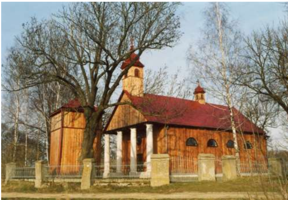
Kamionacz - kościół p.w. Św. Marcina fot. M. Urbański
