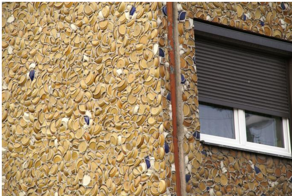
Fot. Elewacja „talerzowa”
