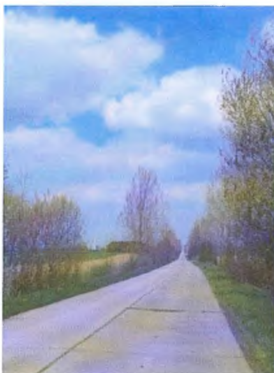
Betonówka – stan obecny
